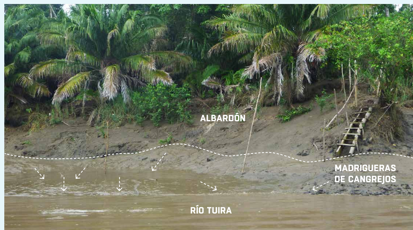
FIGURA 23: (a) Sector del albardón con madrigueras de cangrejos aledaño al pozo GW-T1-1. (b) Detalle de la madriguera de un cangrejo, (c) Vista del albardón desde el cauce del río Tuira indicándose en línea punteada la descarga subterránea desde el albardón hacia el río.
